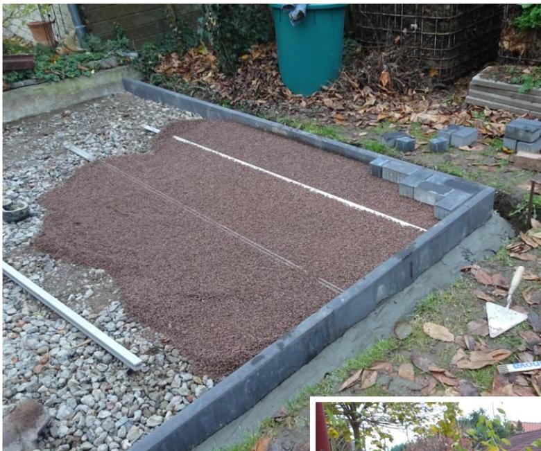
sind schließlich alle Randsteine gesetzt. Nun wird mit Splitt der erste Teil des Pflasterbettes hergestellt, wozu waagrecht
