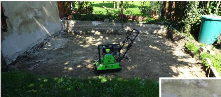
Pflasterniveaus ansetzen kann, was besser vor den Pflasterarbeiten zu erledigen ist. Am 09.09. verdichte ich die ausgehobene Fläche mit einem frisch
