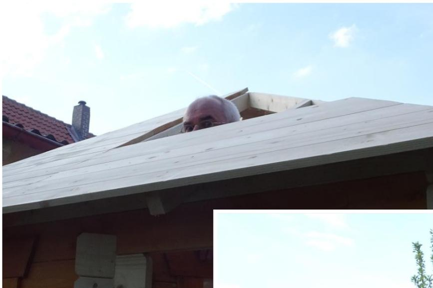
Transport vom Ort des Zusammenbaus zum Montageort übersteht. Jetzt werden die langen Diagonalsparren montiert und zum Schluss die Hilfssparren. Es gibt acht Sätze von Dachbrettern, wovon jedes ein Dreieck ergibt. Drei dieser
