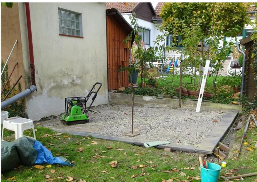
Am 29.10. hole ich mit meinem Neffen Mineralgemisch und Splitt. Das Mineralgemisch wird mit Schubkarren in die Grube gekarrt, gleichmäßig verteilt und schließlich verdichtet.
