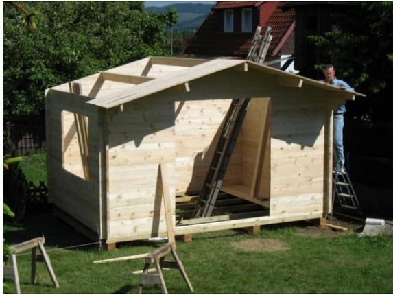
langsamer voran, als das Zusammenstecken der Blockbohlen, da die Dachlatten vernagelt werden. Das Grundieren der Dachfläche danach geht allerdings wesentlich schneller.
