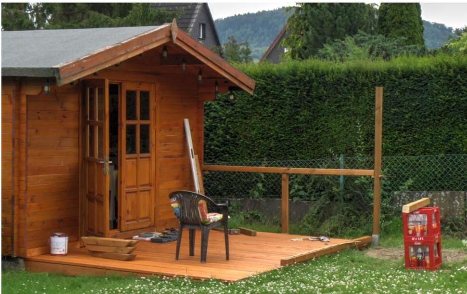
Mehraufwand in Grenzen. Bei der folgenden Konstruktion ist die größte Herausforderung noch die Fixierung der Einzelteile zum Vorbohren der Pfosten. Nachdem die Konstruktion einmal steht, nehme ich sie in zwei Teilen ab, um die Schnittstellen mit Imprägnierlasur zu schützen. Nun setze ich alles wieder zusammen. Die Bohrungen des Forstner-Bohrers verschließe ich mit Querholzplättchen. Zwei Blenden am Gartenhaus vollenden schließlich den Verandabau.
