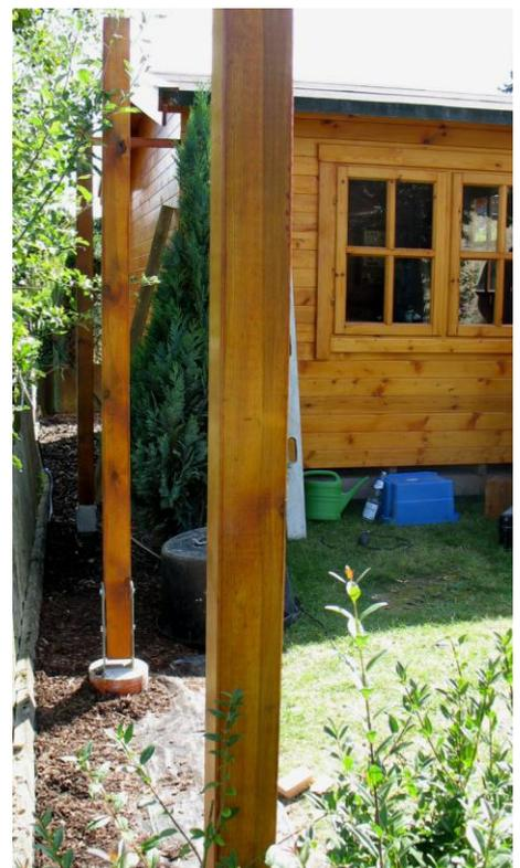
Während der Beton abbindet, werden die Sichtschutzelemente und Pfosten in der Farbe des Gartenhauses lasiert. Da sie kesseldruckimprägniert sind, verzichte ich auf eine Grundierung. Schließlich befestige ich die Pfosten in den Pfostenankern bzw. der Bodeneinschlaghülse und richte sie aus. Anschließend werden die Sichtschutzelemente zwischen den Pfosten befestigt.
