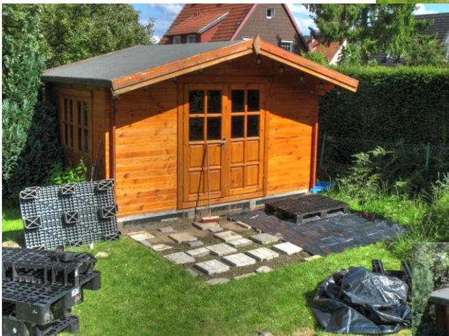
beim Ausheben des Erdreiches, was erforderlich ist, um ein Gefälle vom Haus weg zu realisieren. Mit Gehwegplatten und Verbundpflastersteinen schaffen wir die Auflager für die Paletten. Eine kleine Herausforderung sind dabei unterschiedlich hohe Paletten. Der Unterbau steht
