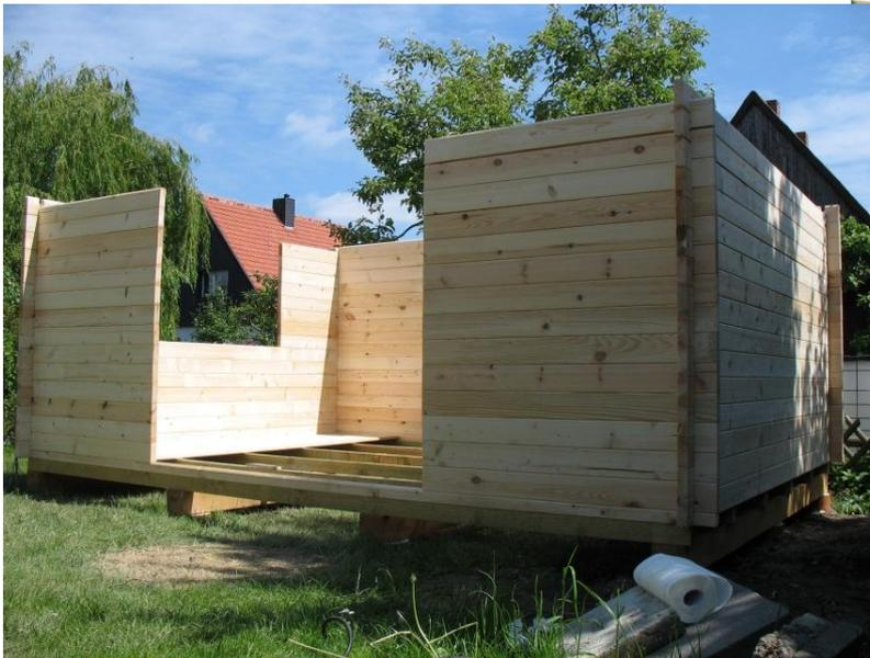
ein Naturprodukt ist und tatsächlich arbeitet. Das Holz ist teilweise so stark verzogen, daß zwischen Doppelnut und -feder ein Luftspalt bleibt. Es empfiehlt sich, die am stärksten verzogenen Bohlen möglichst weit unten zu verbauen, damit die Masse des Aufbaus sie so zusammenpreßt, daß die Luftspalte weitgehend verschwinden.
