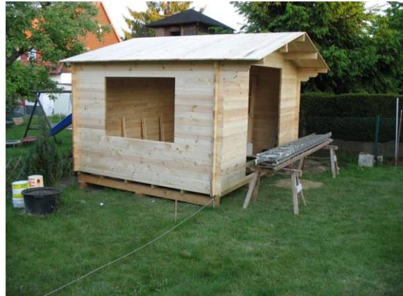
Dicht wird das Dach durch das Aufnageln von Dachpappe. Um hinterher nicht großartig geradeschneiden zu müssen, richten wir die unteren Bahnen möglichst gut aus und arbeiten uns nach oben vor. Nun werden Fenster- und
