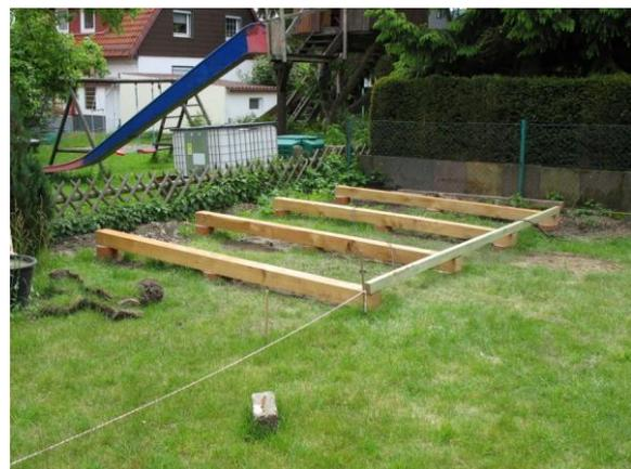
Die Verbindung zwischen den Kanthölzern und den Fundamenten habe ich mit Betonschrauben hergestellt. Genial, diese Schrauben, aber im Baumarkt nicht zu bekommen. Es wird ein Loch in den Beton gebohrt und gut ausgeblasen. Die Betonschrauben werden durch das vorgebohrte Holz gesteckt und direkt (ohne Dübel o. ä.) in den Beton geschraubt. Das ist wesentlich schneller und einfacher, als z. B. mit Betonankern oder Verklebungen zu arbeiten. Zudem ist es auch noch preiswerter.
