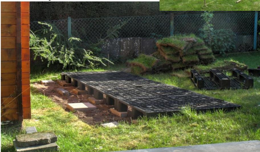
für eine hölzerne Ausführung. Über die Unterkonstruktion mache ich mir lange Gedanken und lande schließlich bei Kunststoff-Europaletten. Die Fläche wird abgesteckt und "probebesessen", um die Anzahl der benötigten Paletten zu ermitteln. Ich bin drauf und dran, Paletten im
