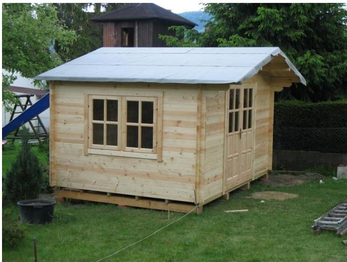
Nun wird das ganze Haus von außen zweimal lasiert, damit es möglichst lange ansehnlich bleibt. Giebelleisten und Zierrauten werden montiert und geben dem Haus den letzten Schliff. Rings um das Haus wird ein schmaler Graben ausgehoben. Dieser nimmt ein feinmaschiges, verzinktes Drahtgitter auf, das mit dem Unterbau vernagelt wird und als Unterkriechschutz vor
