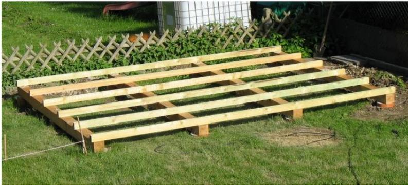
Unterbaus ist möglichst genaues Arbeiten wichtig, wenn später alles passen soll. Damit kein Unkraut unter dem Gartenhaus wachsen kann, haben wir den Boden zwischen den Fundamenten später mit wasserdurchlässigem Kunststoffgeflecht abgedeckt, das wir mit alten Gehwegplatten beschwerten.
