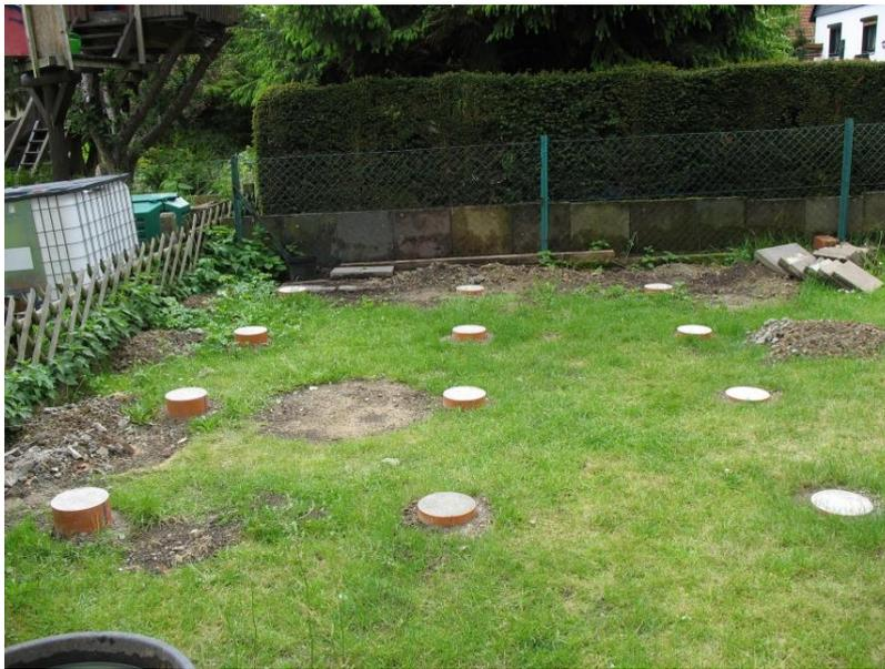
(frostsicher!) tief geschachteten Fundamente werden Rohrstücke gesteckt und fixiert. Die senkrechte und waagerechte Ausrichtung dieser Verschalungen ist Fummelarbeit, aber je präziser hier gearbeitet wird, desto einfacher läßt sich später der Unterbau herstellen. Da ein Teil der Verschalungen sichtbar bleibt, sieht ein sorgfältig ausgerichtetes Fundament auch besser aus. Nach dem Verschalen werden die Fundamente mit Beton
