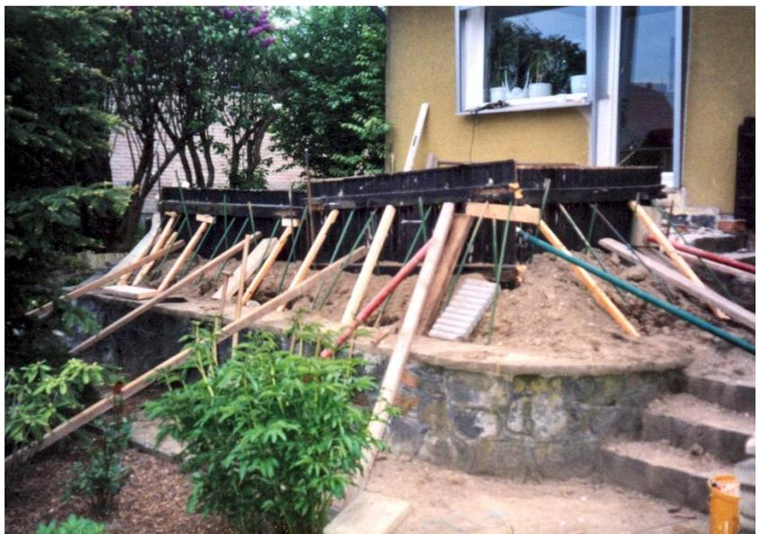
Mai 2004: Der Beton sollte bewehrt sein. Also wurden Stahlmatten angepaßt und ausgelegt. Besonderes Augenmerk wurde dabei auf die Bewehrung des entstehenden Ringfundamentes gelegt. Die Verschalung wurde, so gut es ging, auch von innen gesichert, ein ungutes Gefühl angesichts der acht Tonnen Beton, die benötigt wurden, blieb jedoch. Da der Betonlieferant nicht mit dem Mischer bis zur Terrasse kommen würde, komplettierte eine Rampe für Schubkarren die Konstruktion.
